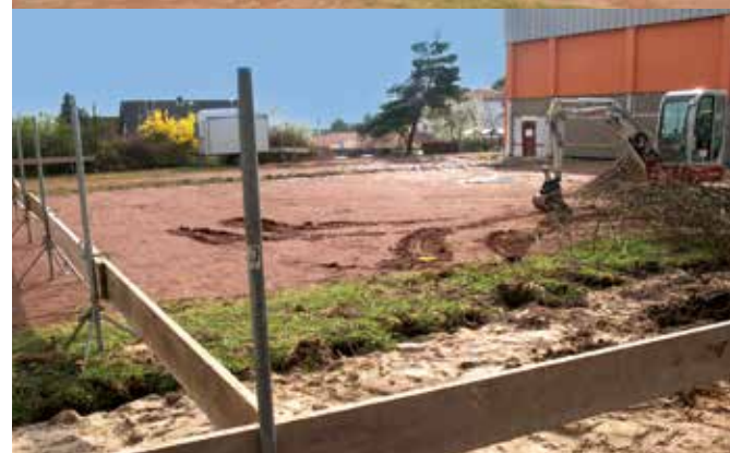
Der Platz für die neue Halle für Alle wird planiert.
