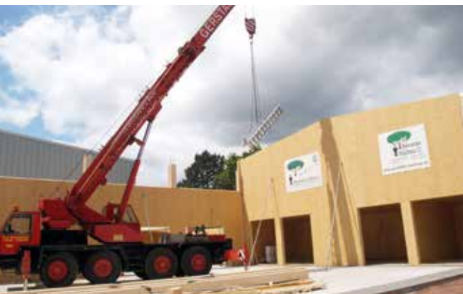
Errichtung der Halle von März bis Juli 2008. Ende Juli wird Richtfest gefeiert.
